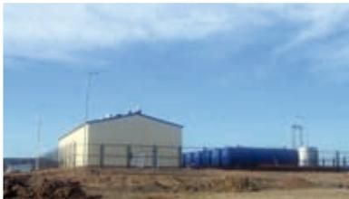
Станция подготовки питьевой воды с резервуарным парком производительностью 2400 м<sup>3</sup>/сут. с резервуарным парком общим объемом 700 м<sup>3</sup>
