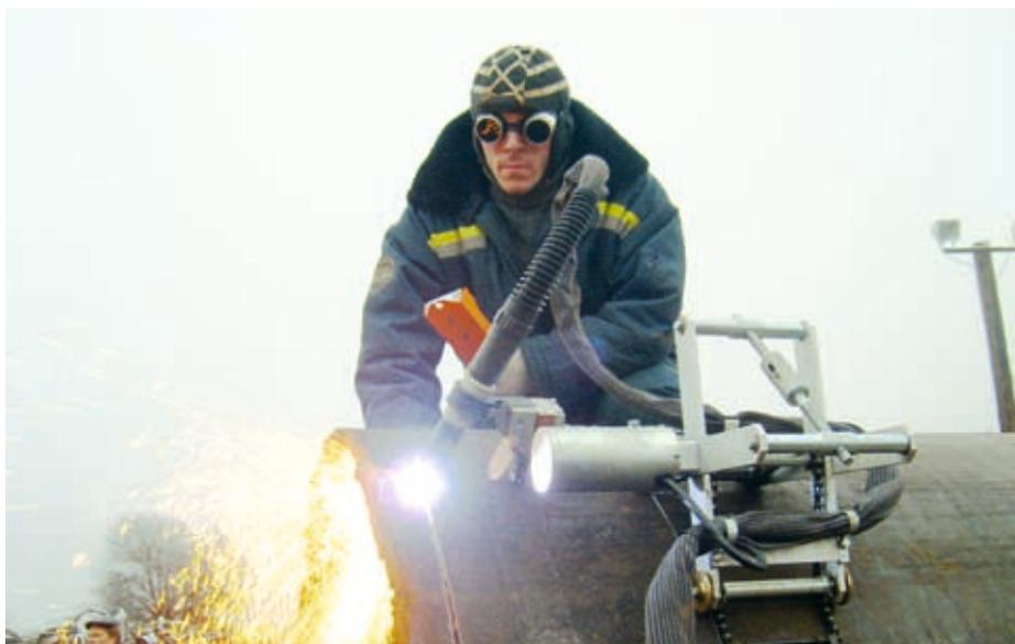
Автоматическая воздушно-плазменная резка трубы диаметром 1 420 миллиметров
