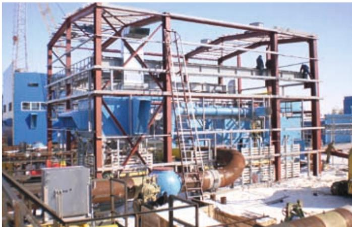
Монтаж ГПА и технологических трубопроводов на Вынгаяхинском ГП
