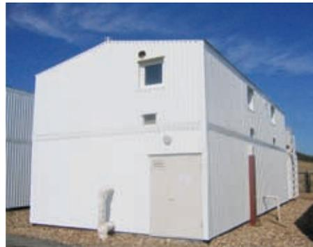
Блочно-модульная станция биологической очистки хозяйственно-бытовых сточных вод «Биоресурс» (БР-200). Модельный ряд модульных станций биологической очистки серии «Биоресурс»: БР-20 – БР-15000 м<sup>3</sup>/сут.
