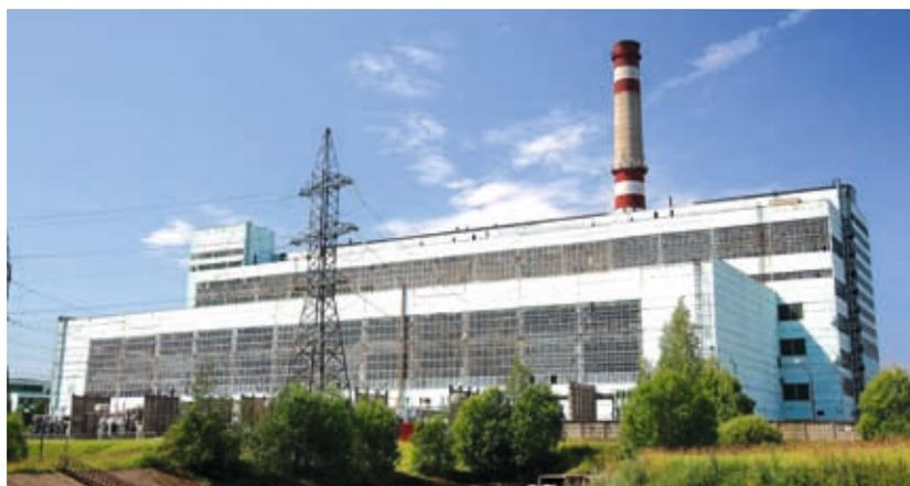
твердого топлива, включая сланец, угли из Хакасии, Узбекистана и Польши. В связи с использованием непроектных видов топлива оборудование станции реконструировалось и модернизировалось. С 1985 года основными видами топлива стали природный газ и уголь.
