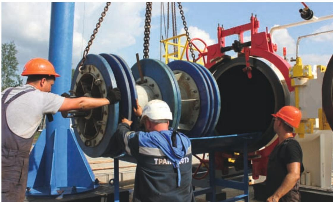
Запасовка очистного устройства на камере пуска средств очистки и диагностики НПС № 24
