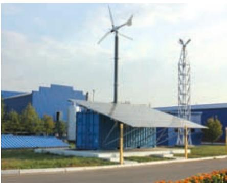
БКЭС-СМ-ВЭУ с использованием солнечных модулей и ветроэнергетической установкой крыльчатого типа на территории завода филиала «Афипэлектрогаз»
