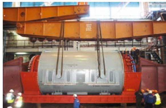
Работы по демонтажу и монтажу статора генератора энергоблоков 800 МВт
