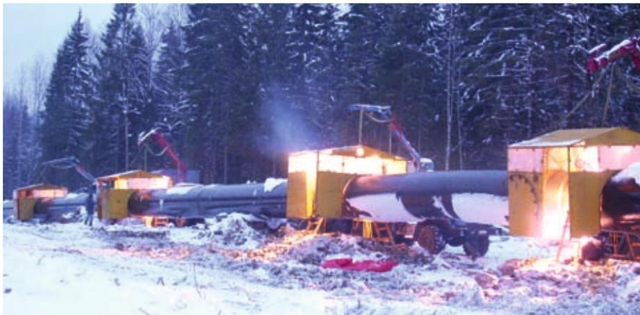
Автоматическая сварка установками УАСТ-1 газопровода Грязовец — Починки диаметром 1 420 миллиметров
